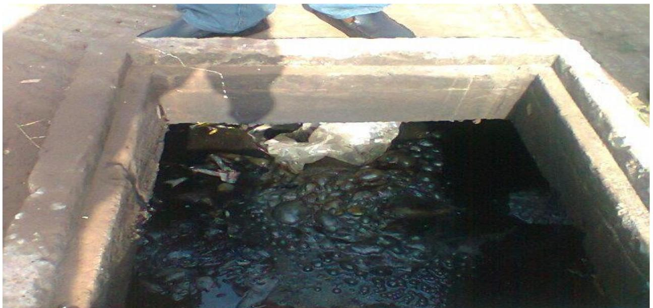
**Fig.20: le remplissage du séparateur à hydrocarbure maçonné**
