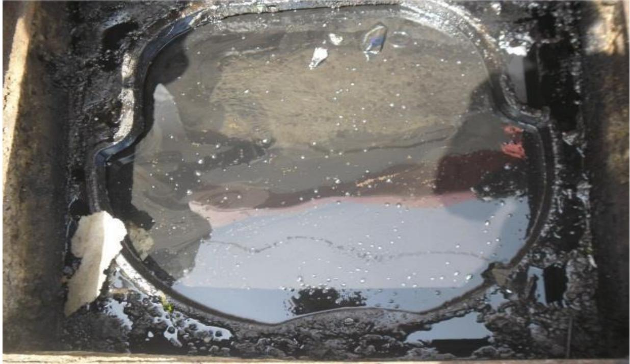
**Fig.21: remplissage du séparateur à hydrocarbure préfabriqué**
